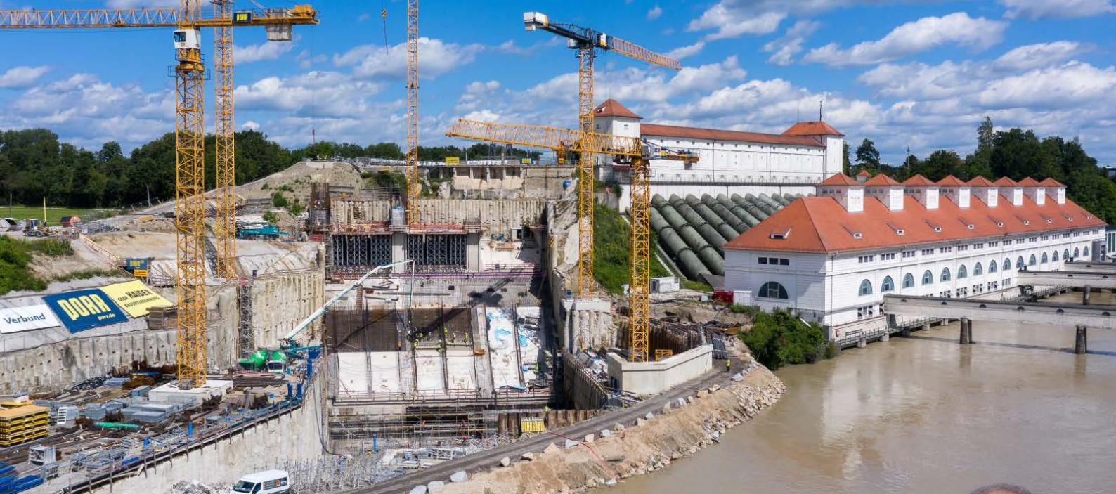
6.2.2: Töging-Instandsetzung und Neubau
