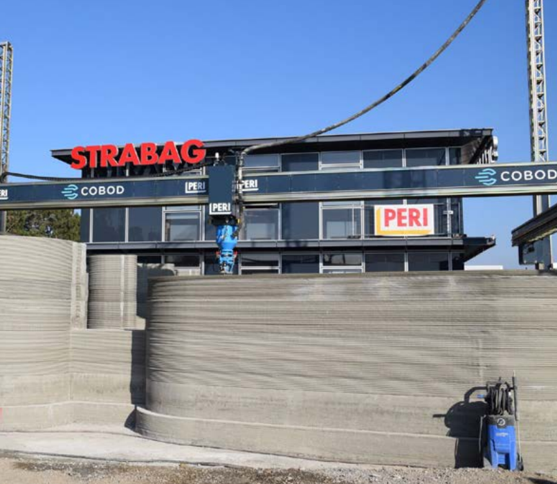
3.2.1: Erstes 3D-gedrucktes Haus in Österreich.
