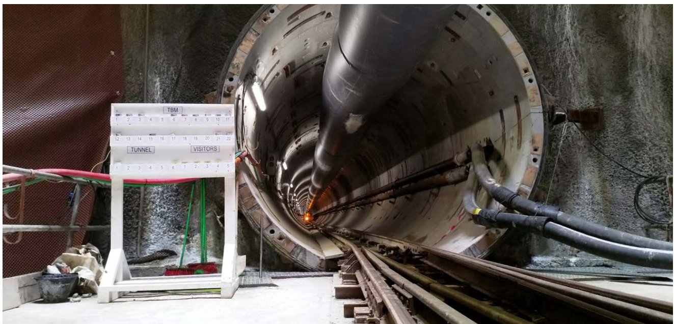
6.2.4 : 10 km langer Abflusstunnel in Doha mit Stahlfasertübbingen
