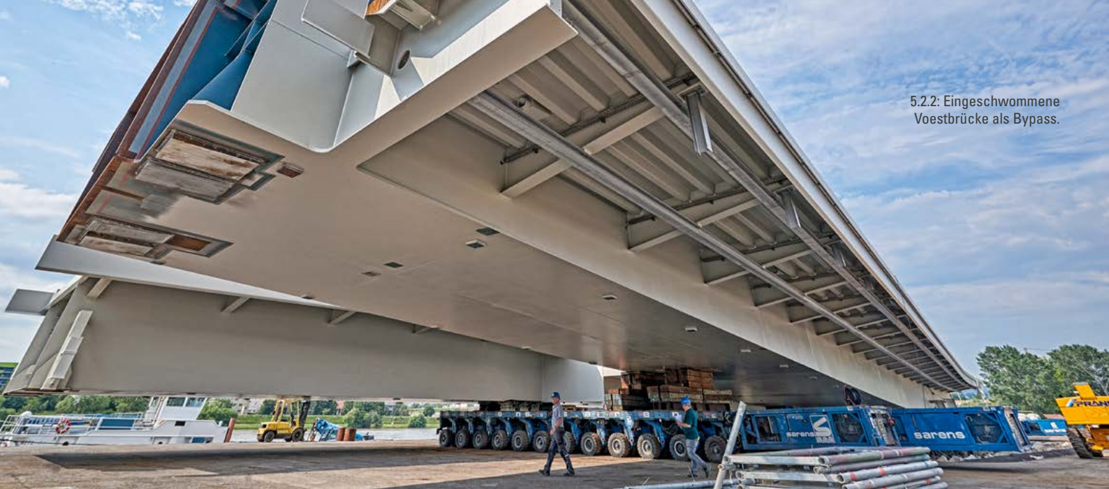
5.2.2: Mehr Stahl als im Eiffelturm: Zwei neue Bypassbrücken für die A7-Voestbrücke in Linz.
