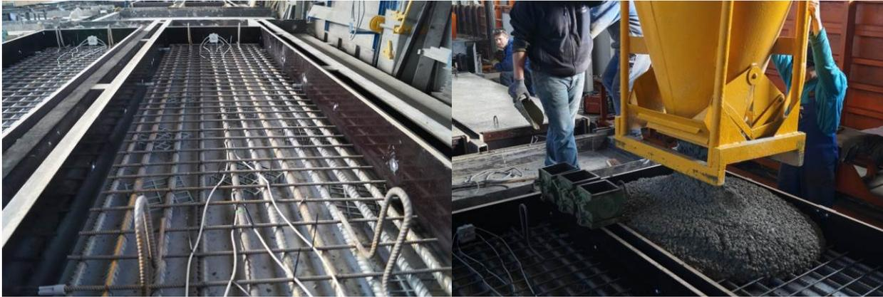
Abbildung 6: Herstellung der Grundplatten
