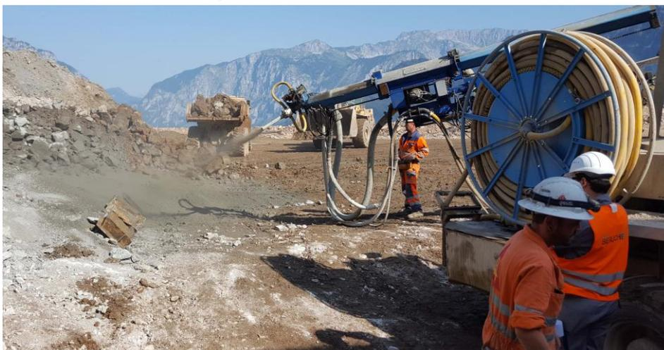
**Abbildung 9: Spritzen von Kisten im Portalbereich (Versuchsgelände des ZaB)**
