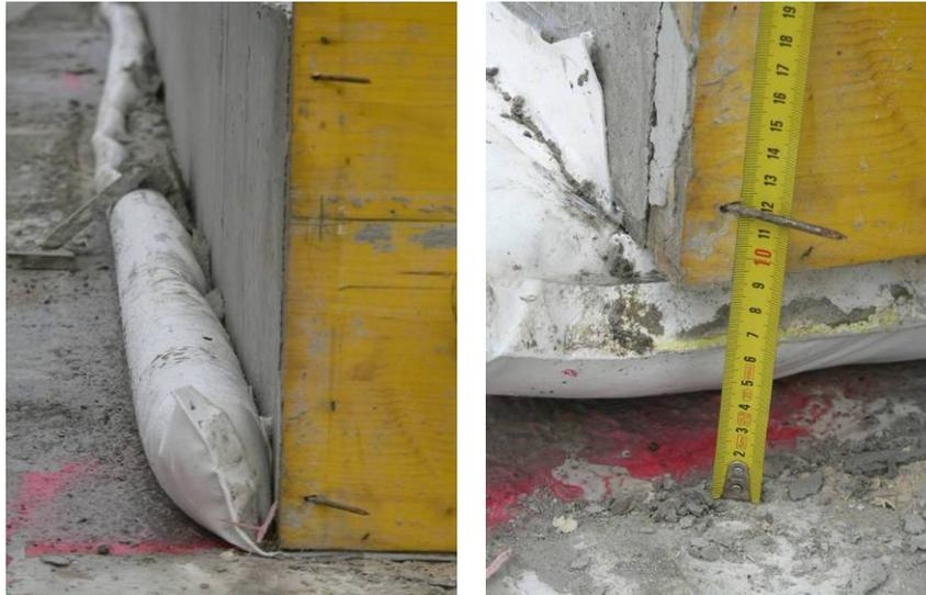
Abb.12: links Luftlagerung kurz vor dem Abheben, rechts abgehobene Platte
