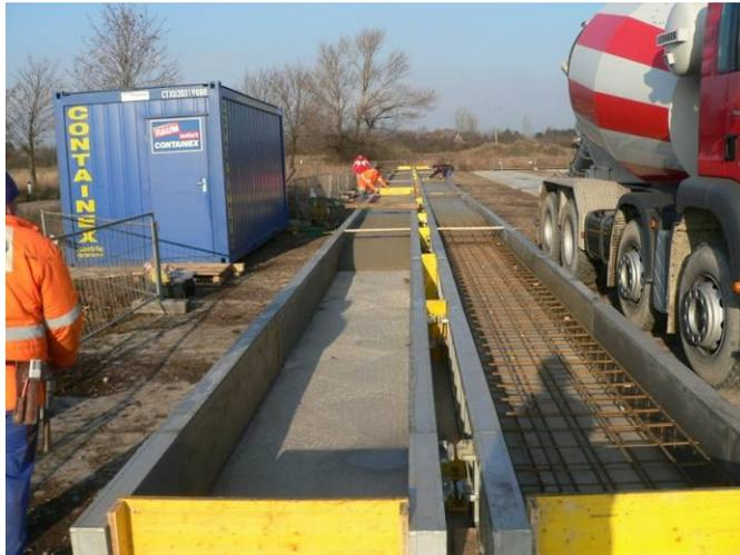
Abb.4: Betonieren Plattenstreifen 1+2
