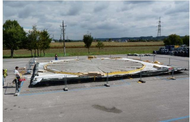
Abbildung 3 Betonplatte nach der Betonage der Platte
