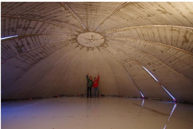
Abbildung 4 Fertiggestellte Betonschale
