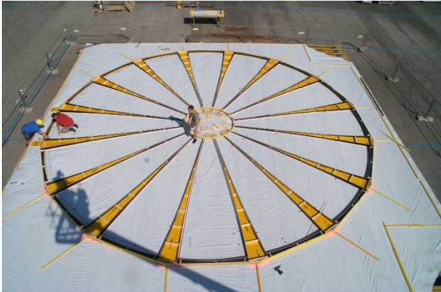
Abbildung 2 Verlegen der Schalung am Unterbauplanum
