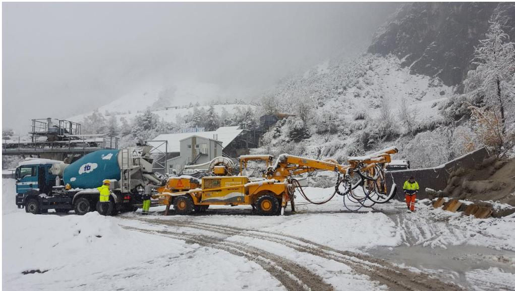
**Abbildung 4: Spritzmobil und seine Beschickung**
