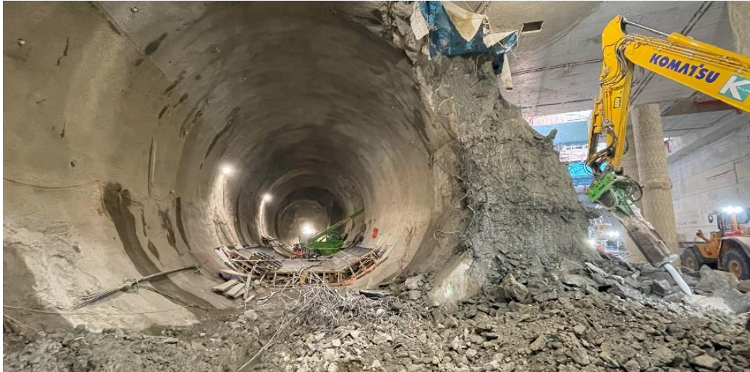
Abbildung 2.3.4: Abbruchvorgang des Widerlagers
