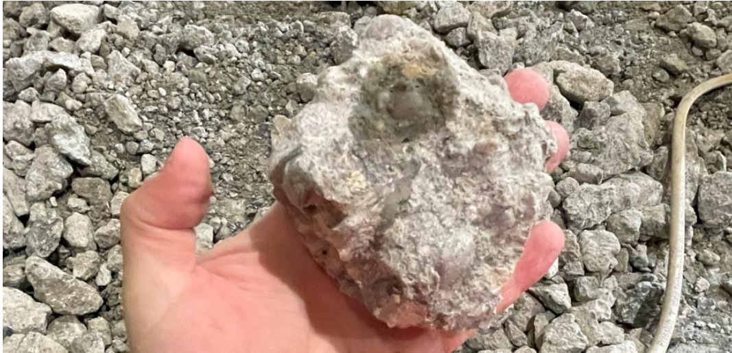
Abbildung 2.3.17: Detailansicht eines Betonbrockens
