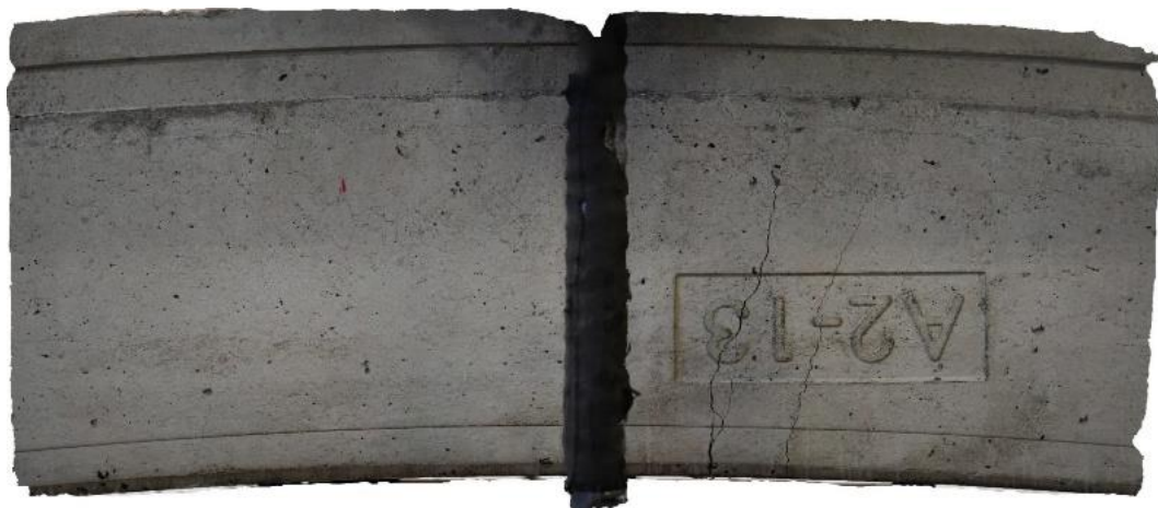
Abbildung 2.6.4: photogrammetrische Rissaufnahme am Tübbingscheitel
