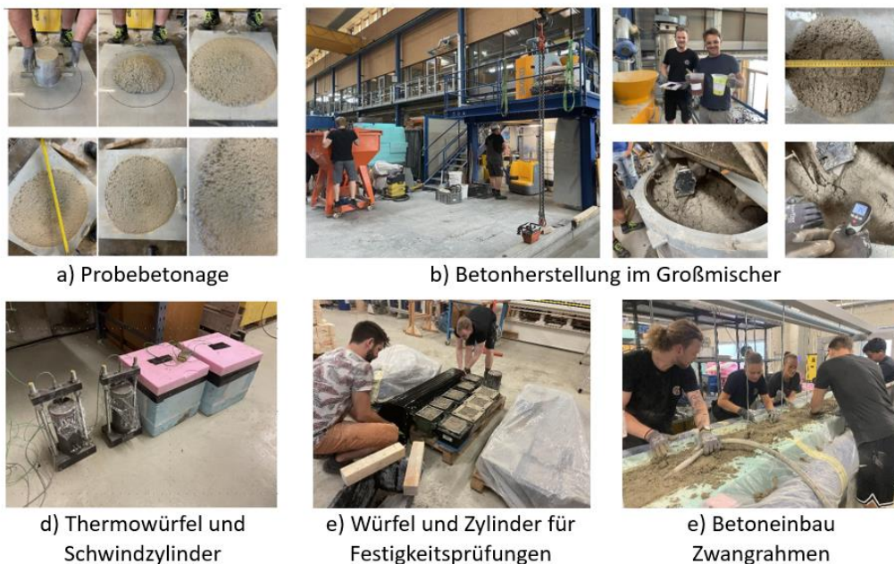
Abbildung 2.3.5: Abb. 5 Arbeitsschritte Betonage
