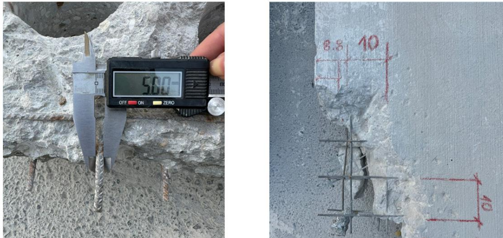
Abbildung 2.4.13: Abb. 20 Zerstörende Freilegung der Bewehrung zur Ermittlung der Stabdurchmesser, Abstände und Anordnung als Grundlage für das numerische Modell.
