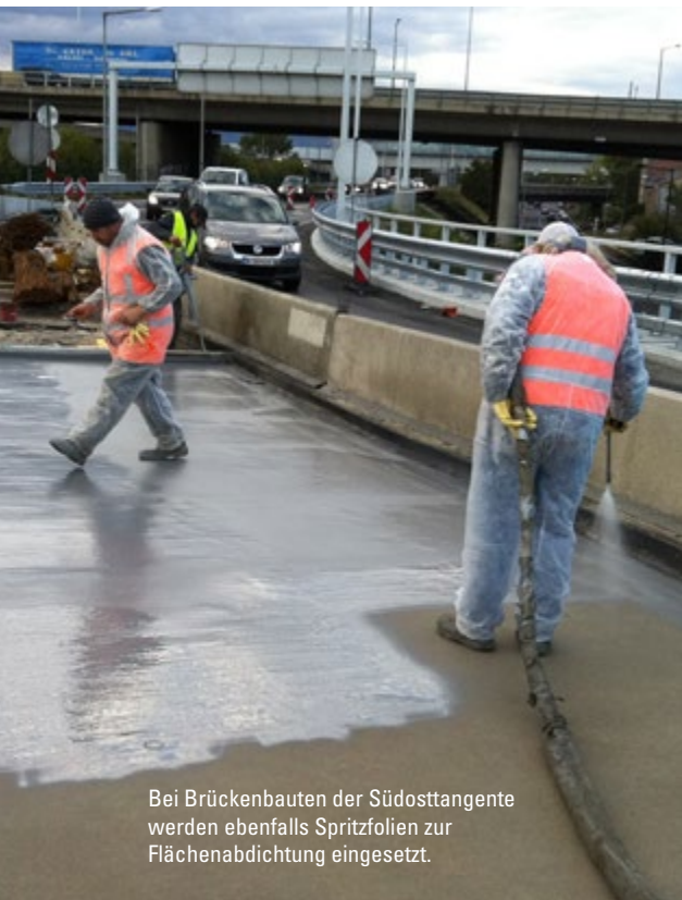
Auch für die MERKUR-Garage in Steyr wurden Spritzfolien für die Dichtung aufgebracht.
